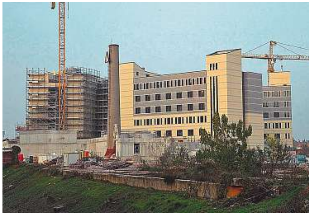
Il complesso del nuovo tribunale ormai ultimato a Borgo Berga
